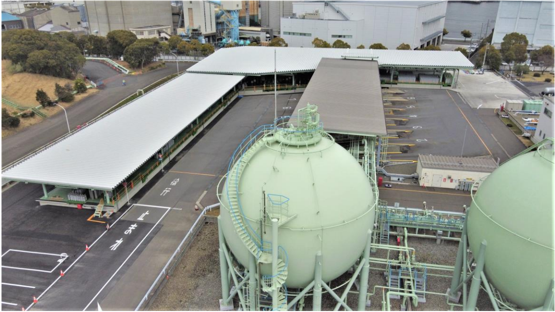
新設のLPGシリンダー充填所（奥側）と既設球形タンク・ローリー出荷設備（手前側）
